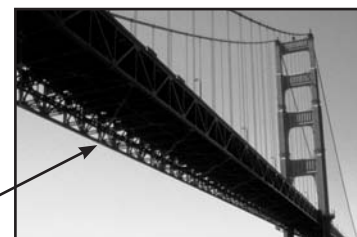
Abbildung 49 - Der Einsatz von Fachwerkträgern bei der Fahrbahndecke einer Hängebrücke
